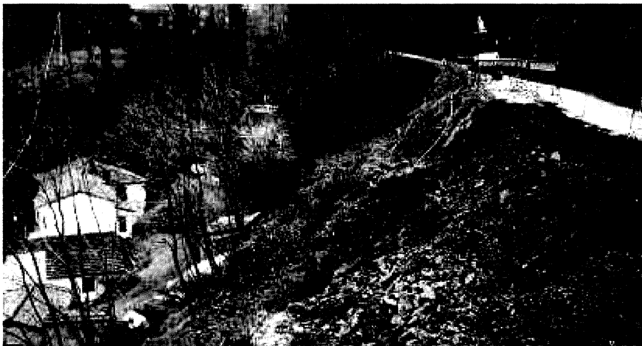
La frana che ha semidistrutto la strada che collega Luiciana a Cantagallo. Completamente isolata la frazione
