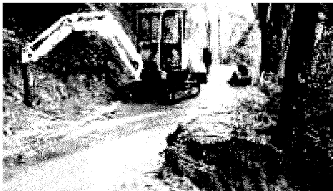
Una ruspa elimina fango e detriti dalla strada
